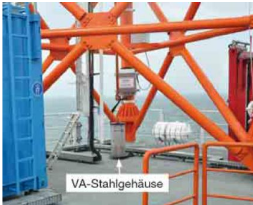
Abb. 5: VA-Stahlgehäuse am Turmfuß
