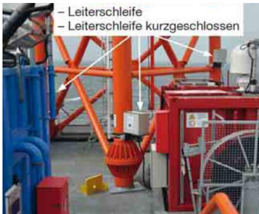
Abb. 6: Leiterschleifen am Turmfuß
